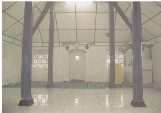
Foto 2. Ruang utama dengan empat tiang sebagai soko guru
