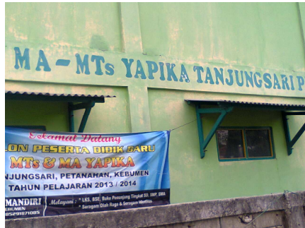
Foto Gedung MA YAPIKA dari arah Timur
