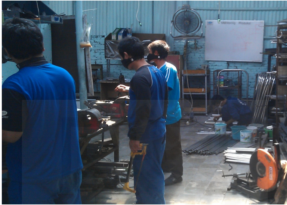
Pemotongan besi dan Pembengkokan besi penyangga Sliding bed
