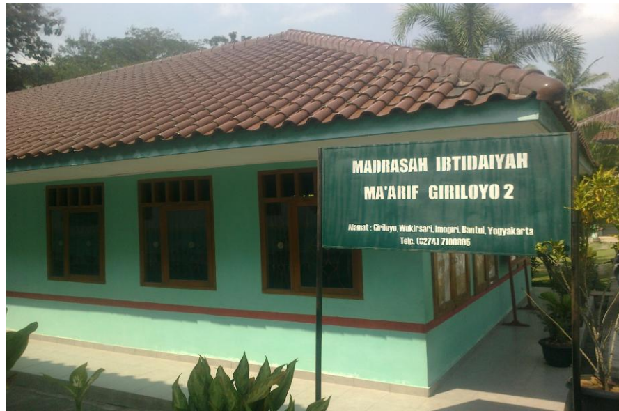
Gambar 01 : Foto Gedung MI Ma'arif Giriloyo 2
