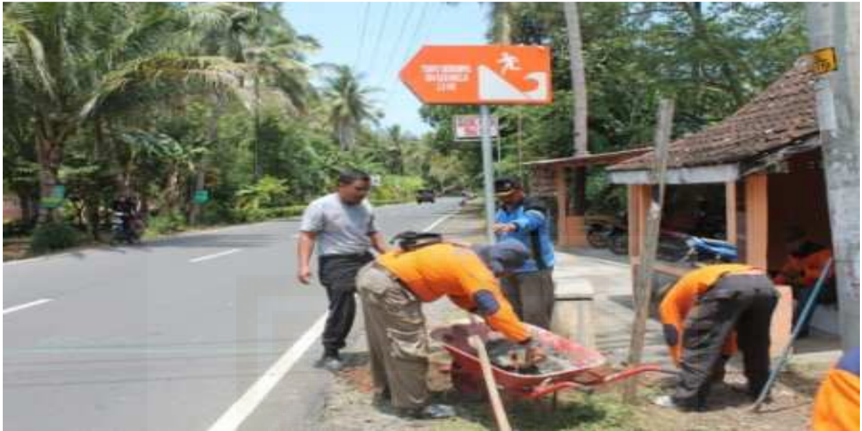
Pemasangan rambu-rambu jalur evakuasi
