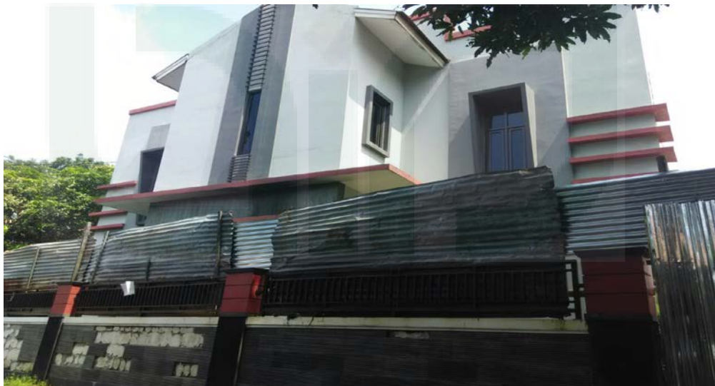
Gereja di Dusun Pangukan pasca kerusakan nampak dari samping kanan
