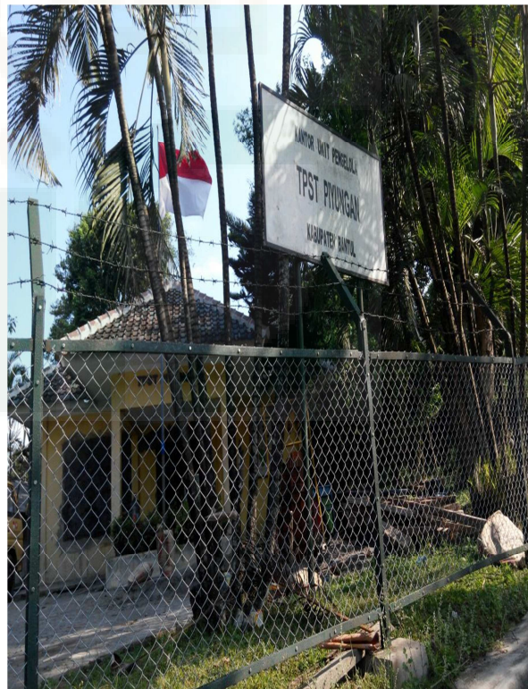
Kantor unit TPST Piyungan
