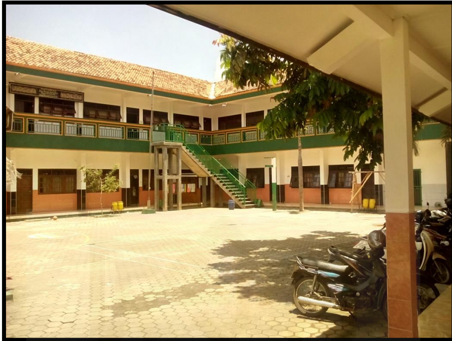
Gedung MITQ TBS Kudus tampak dari depan
