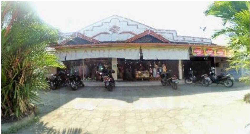
Gambar 13 Bangunan Toko Modern Peni Asri
