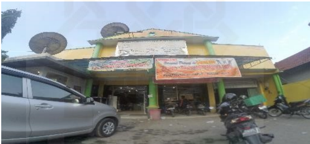
Gambar 11 Bangunan Toko Modern Gading Mas 5
