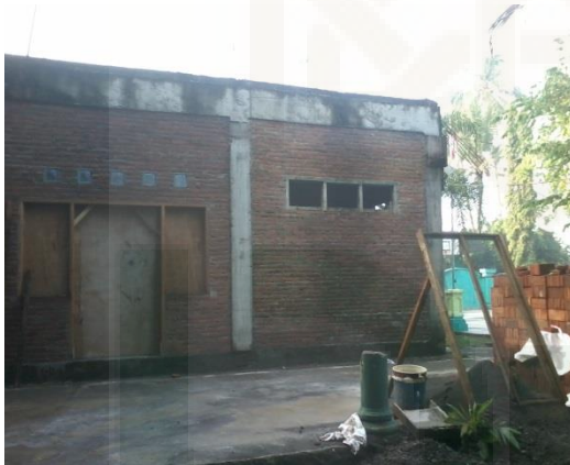
Pembangunan ruangan kelas
