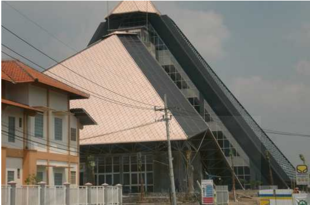
Gambar Museum Gus Dur. Masih dalam proses pembangunan.
