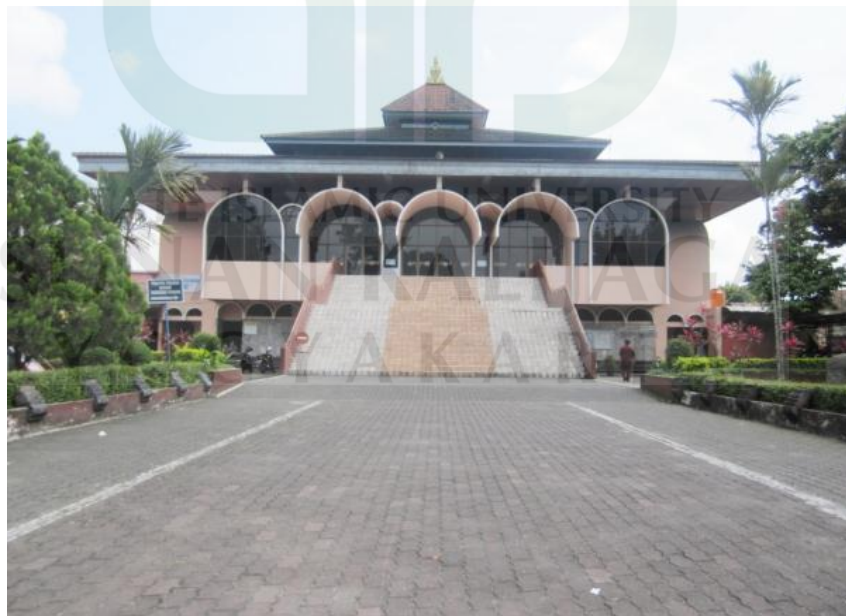
Gambar 16 Bangunan Masjid Agung Jami' sebelum renovasi
