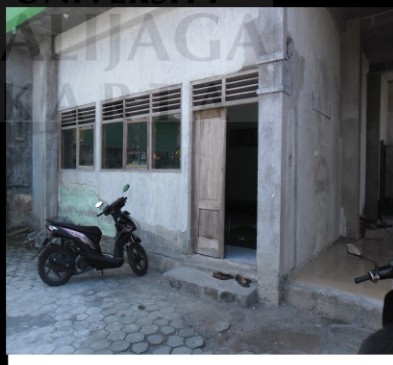
Ruang Perpustakaan MI Ma'arif Candran dalam Proses Pembangunan
