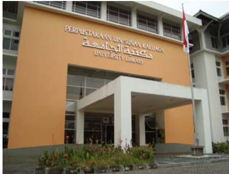
Gedung UPT Perpustakaan UIN Sunan Kalijaga Yogyakarta
