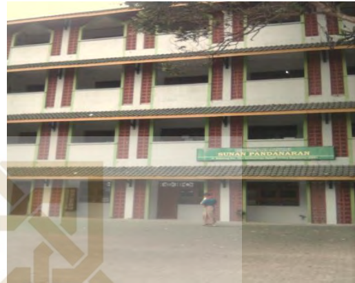
Gedung Madrasah Komplek III Putra
