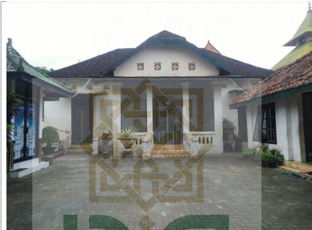
Foto 17: Bangunan yang dulunya difungsikan sebagai KUA
