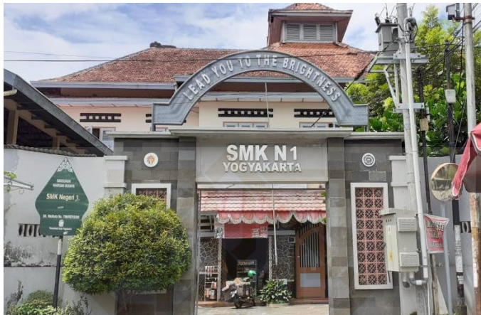
Gambar.1 Gedung Sekoah Tampak Depan
