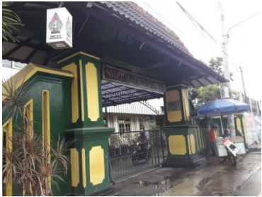
Gedung sekolah tampak depan
