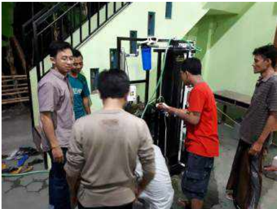
Gambar 28. Pemasangan alat penyaring
