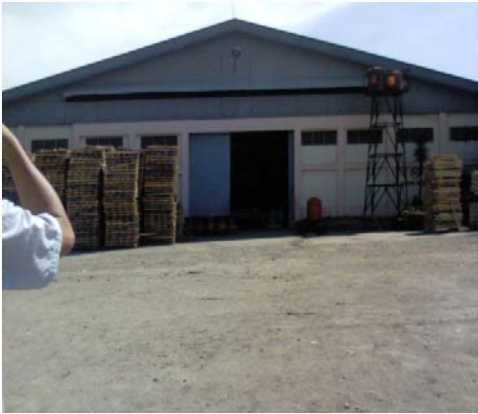
Bangunan untuk karyawan bekerja di PT. WBI Cilacap Jawa Tengah
