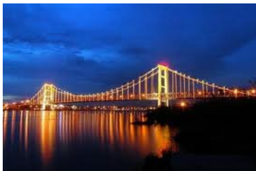
Gambar 1.15 Jembatan Kukar Kaltim Sebelum Runtuh
