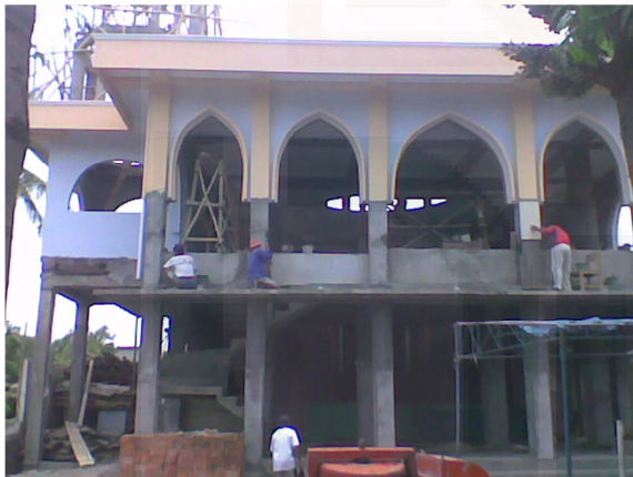
Gambar 11 Proses Pembangunan Masjid (Suasana pengerjaan lantai 2 oleh tukang-tukang ahli pembangunan)
