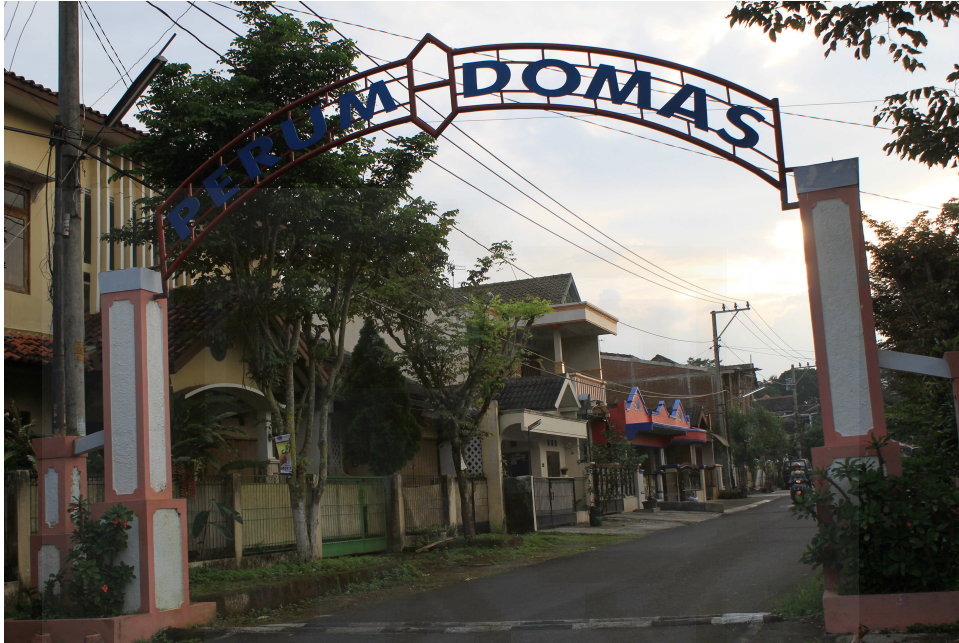
1.1 Gambar jaringan listrik yang sudah diganti oleh PT. PLN (Persero) Unit Layanan Salatiga terlihat kabel listrik jauh dari rumah
