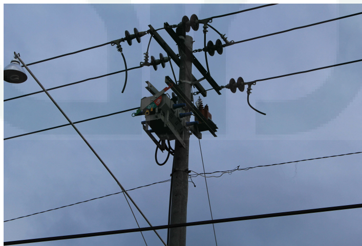
1.2 Jaringan listrik yang sudah diganti dengan feeder 3 phasa
