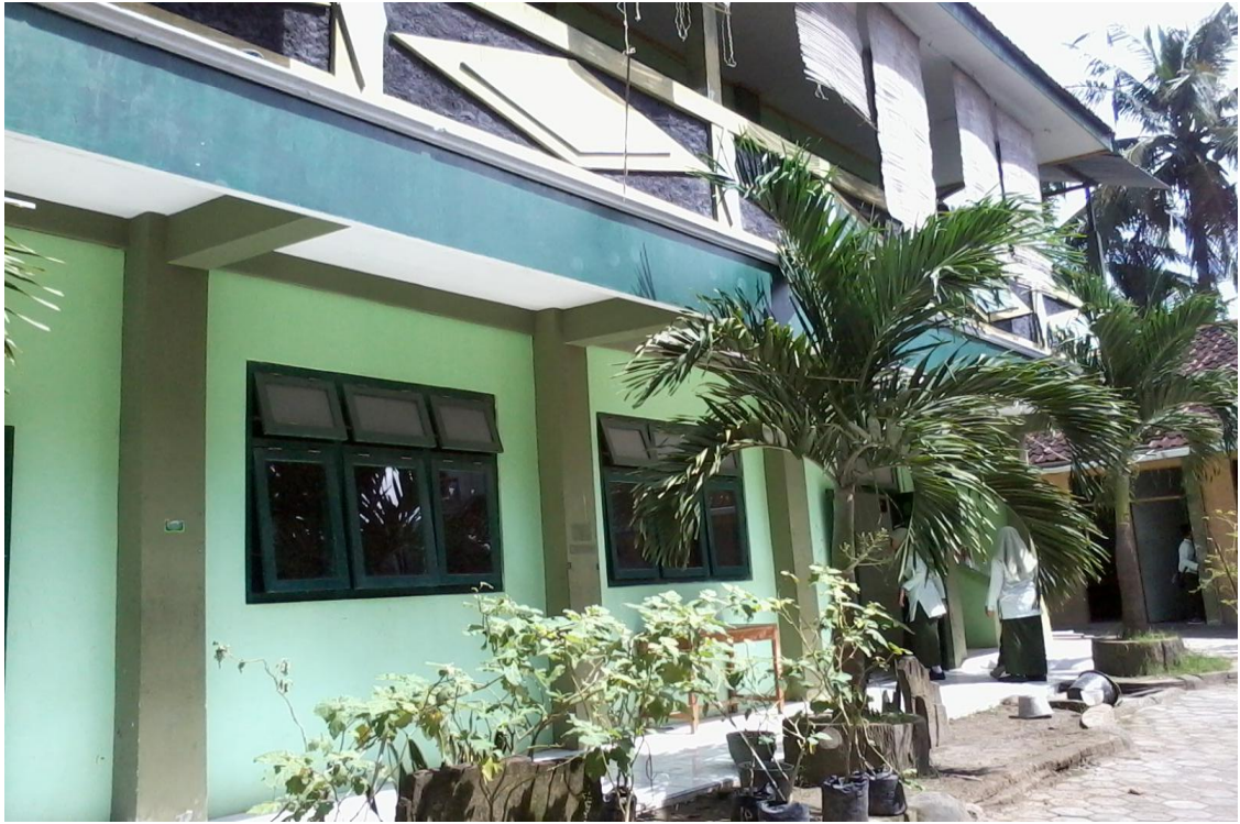
Kondisi ruang kelas PP Al-Imdad
