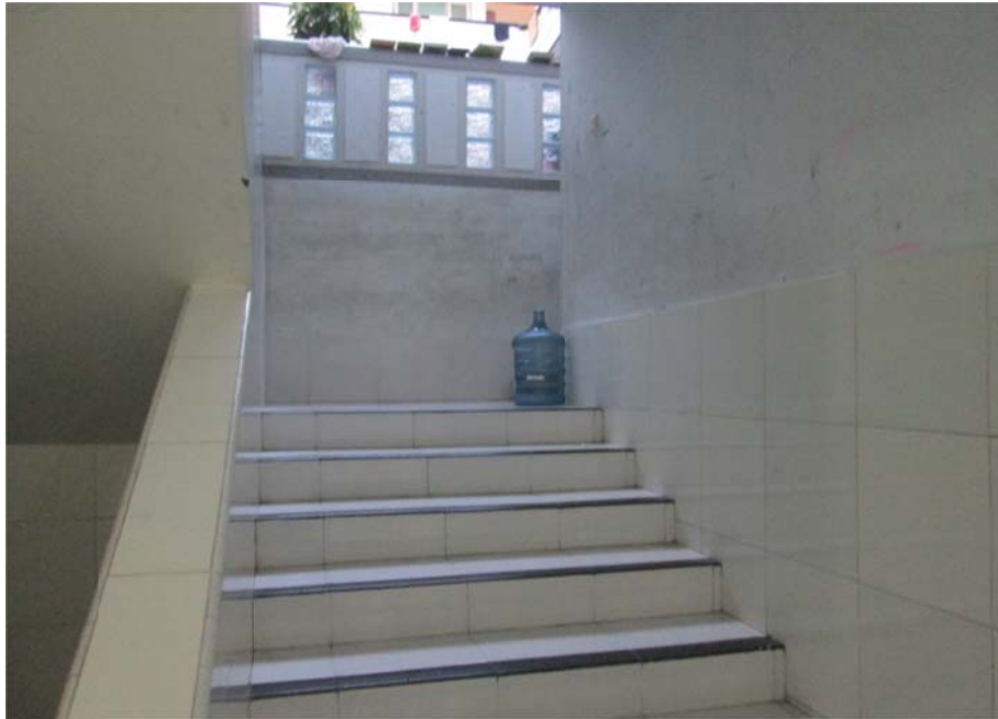
Gambar VII Tangga Menuju Underground
