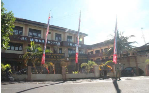
Gedung SMK Muhammadiyah Imogiri
