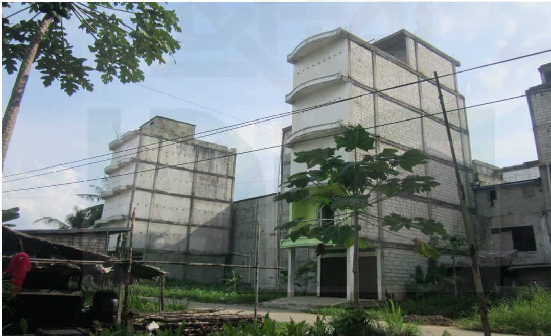
Gambar 14 : Bangunan tempat usaha burung wallet milik komunitas Bugis
