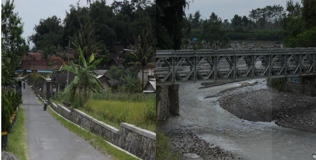
Gambar 14. Infrastruktur Jalandan. Jembatan Menujoke Dusun Gunung Lemah
