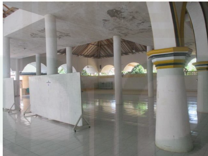
Foto No. 12 Ruangan wanita, pada serambi selatan (Dok. Moh. Sholeh Tamam H.)
