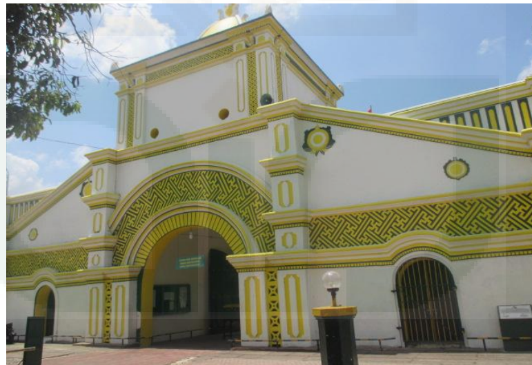
Foto No. 2 Pintu utama yang terdapat pada Gapura Masjid Jamik Sumenep, tampak pada gambar di apit oleh dua kamar sisi kanan, dan kiri. (Dok. Moh. Sholeh Tamam H.)
