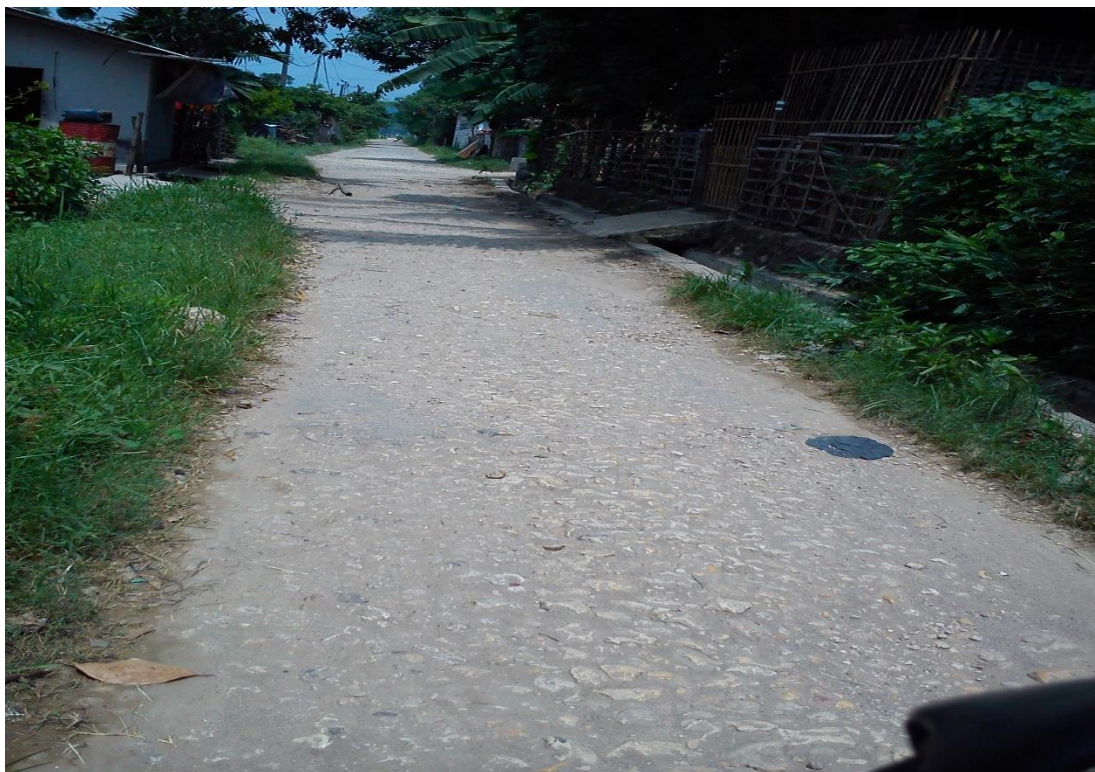
Ket: Jalan Desa
