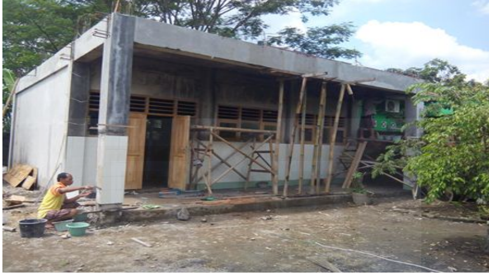
Gambar 20. bangunan yang nantinya akan dijadikan rumah tahfidz
