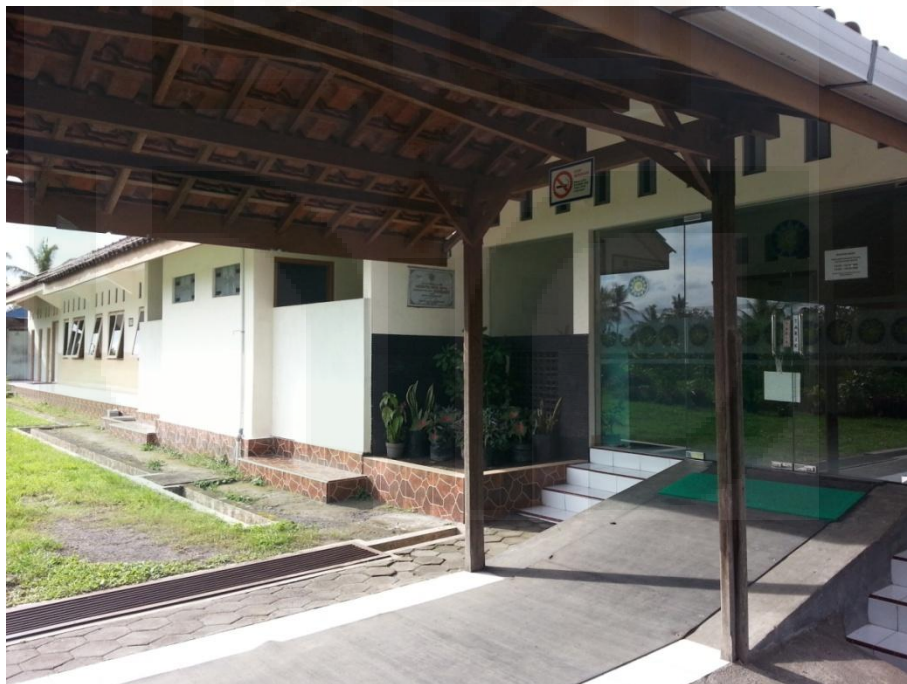
Tampak Luar Gedung Rawat Inap
