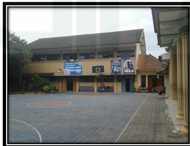
Foto Gedung Sisi Utara SMP Negeri 1 Godean
