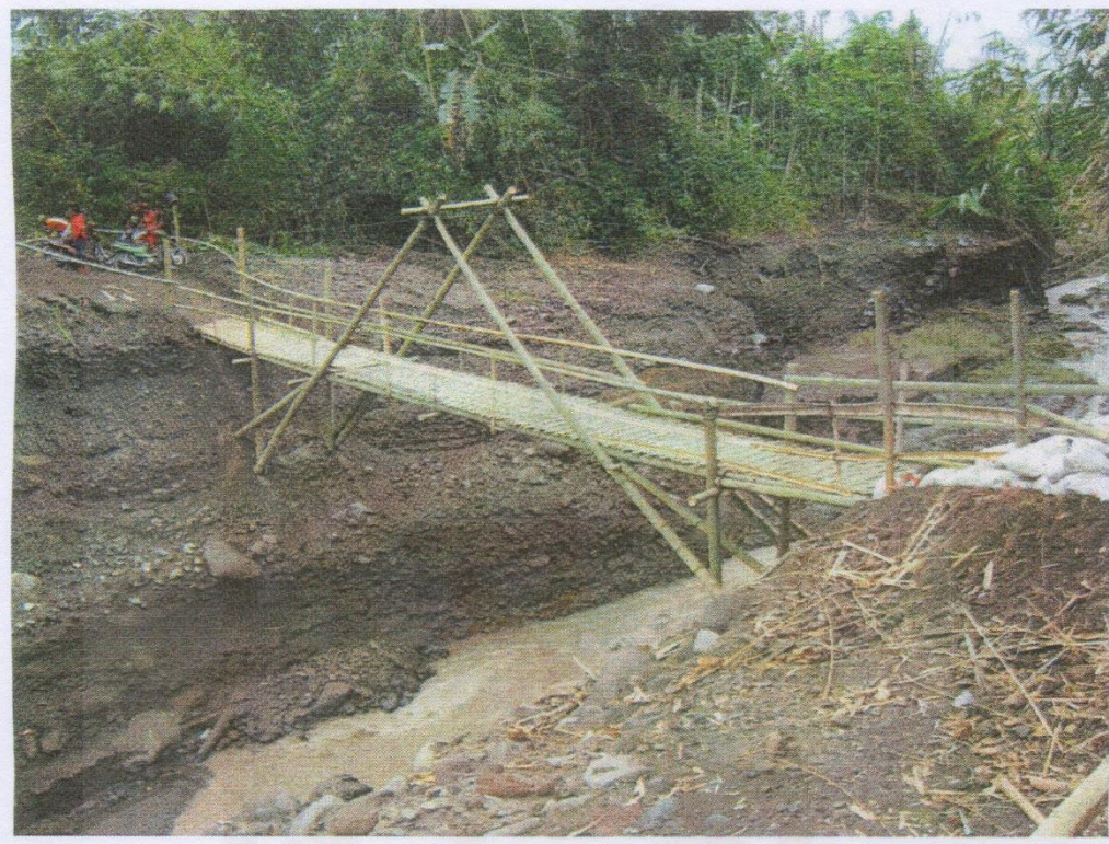
Gambar 2.7 Jembatan Mranggen yang dibangun oleh relawan Paroki St. Antonius Muntilan
