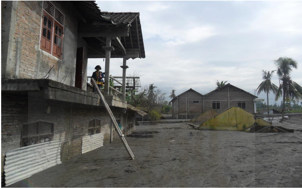
Gambar 5.8 Rumah-rumah warga Dusun Salakan, Desa Sirahan yang tertimbun material pasir setebal 3 hingga 5 meter
