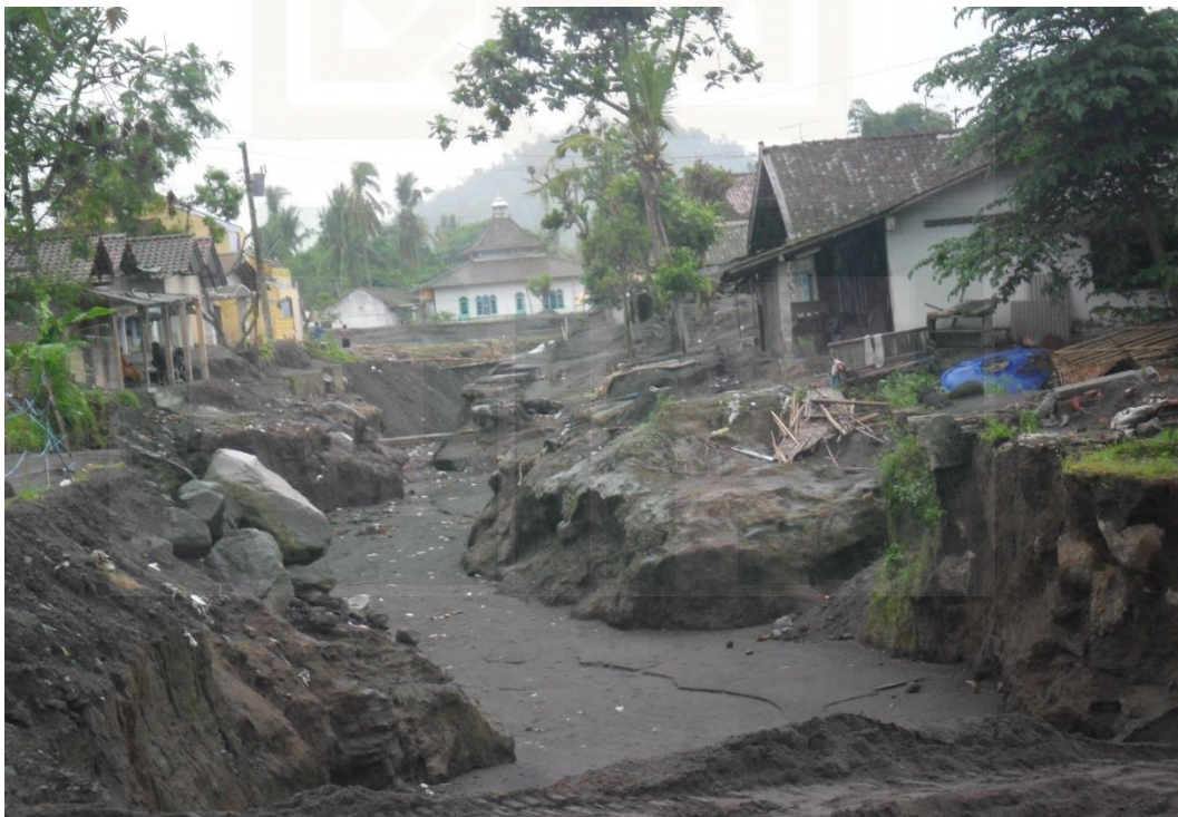
Gambar 5.9 Jalan utama beraspal di Dusun Sirahan menjadi sungai sedalam 2 meter. Tampak Masjid Ibnu Hajar Sirahan tetap berdiri dengan kokohnya.
