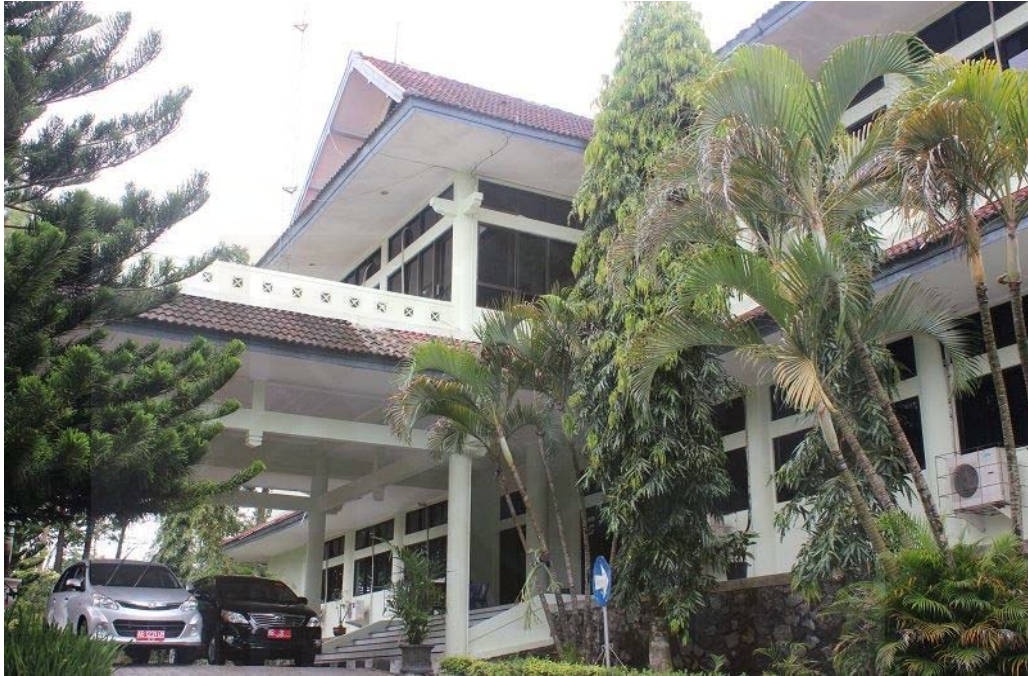
Gedung Kantor Badan Diklat DIY
