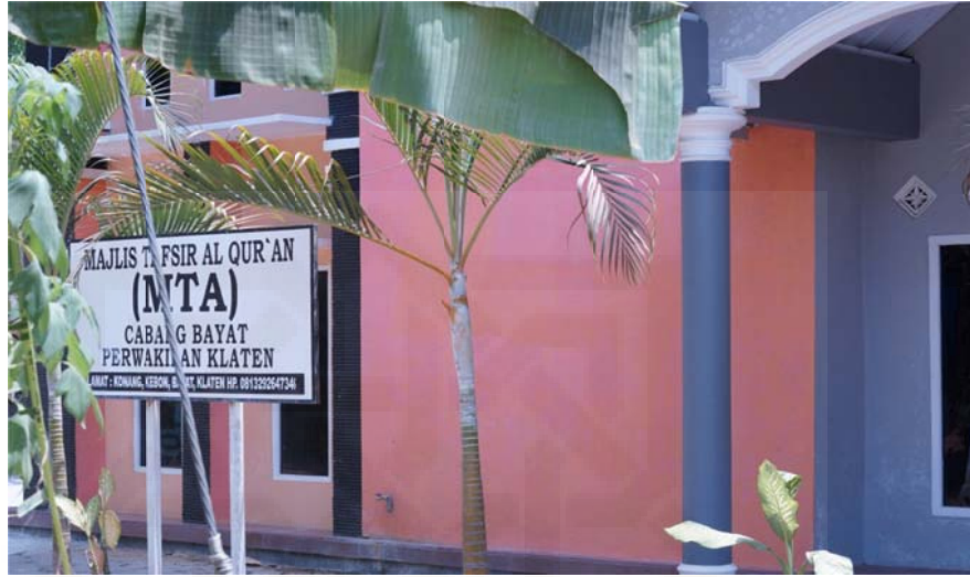
Gedung Majelis Tafsir Al-qur'an Dusun Kunang
