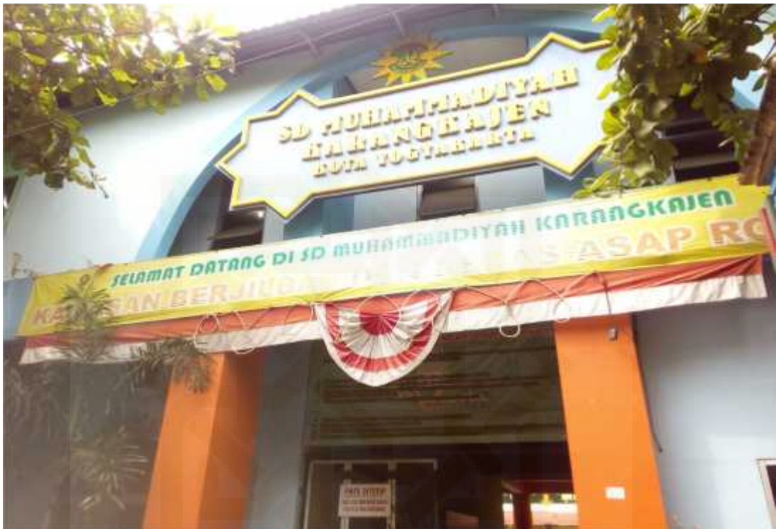
Gambar 1. SD Muhammadiyah Karangkajen II Kota Yogyakarta Tampak Depan
