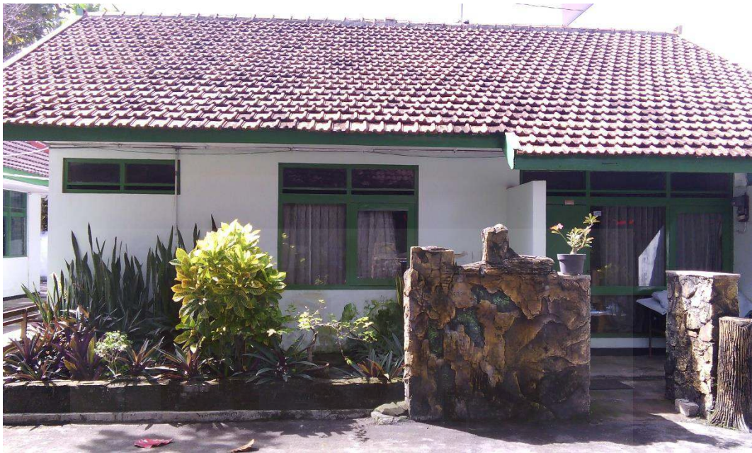
Ruang Penyimpanan (Gudang)
