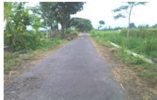
Gambar 10 Jalan menuju sumuran
