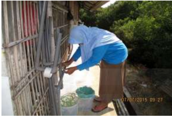
a. Pemasangan aerasi
