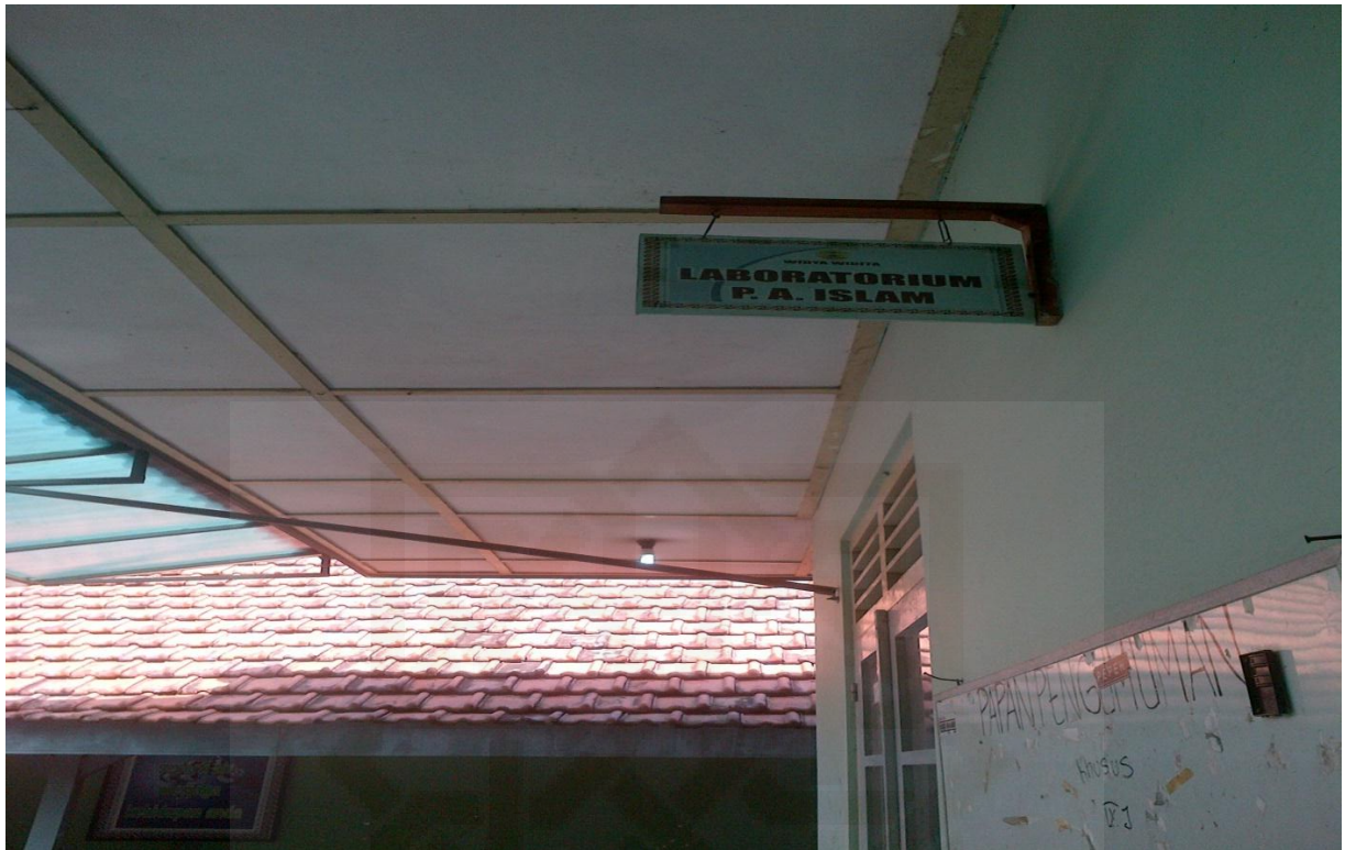
Lokasi Laboratorium PAI sebagai sarana penunjang dalam pembelajaran PAI
