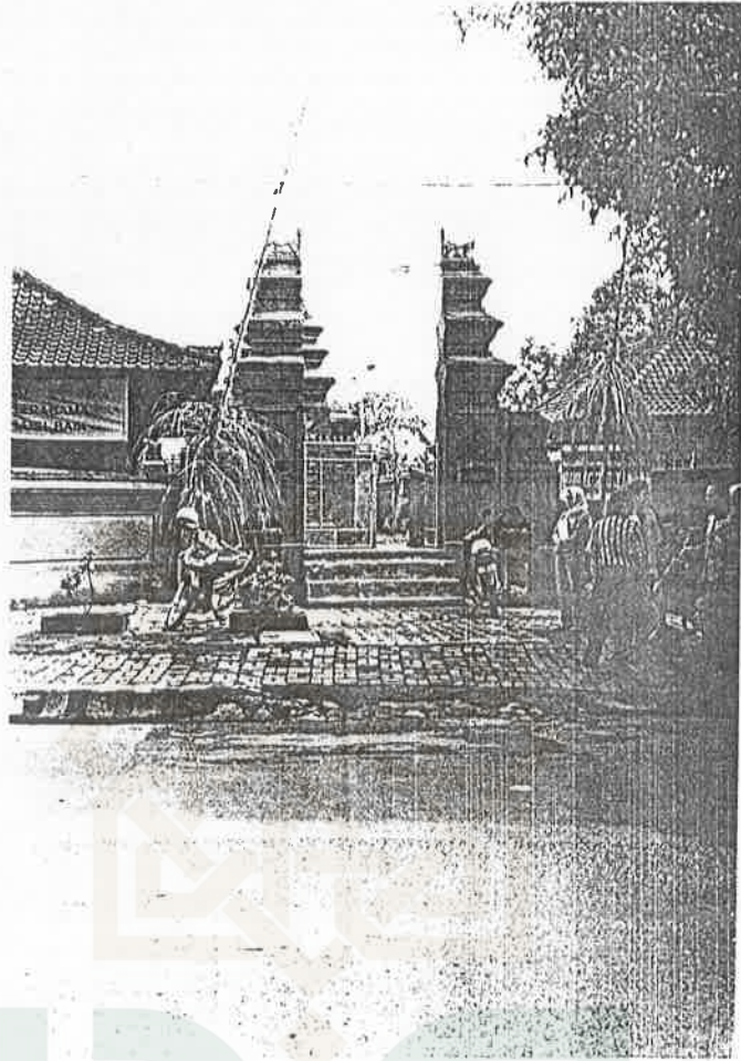
Gapura / pintu utama, untuk memasuki bangunan pura Prastha Praga
