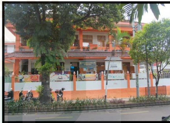
Penampakan gedung dari luar
