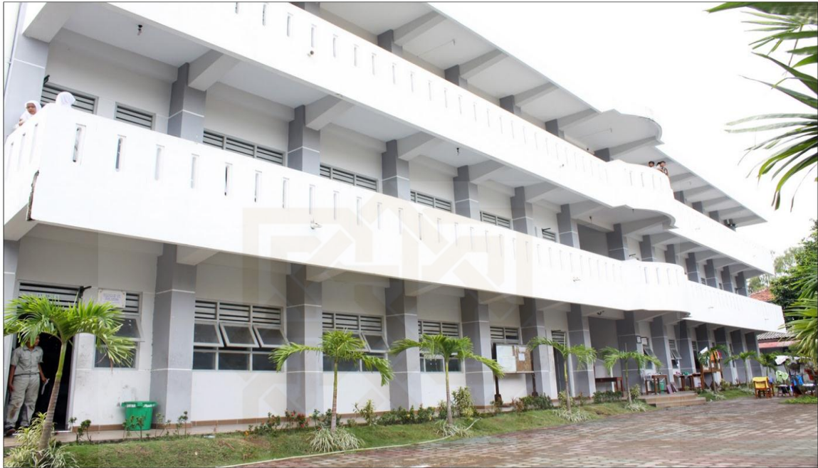
Gedung MTs Ali Maksum
