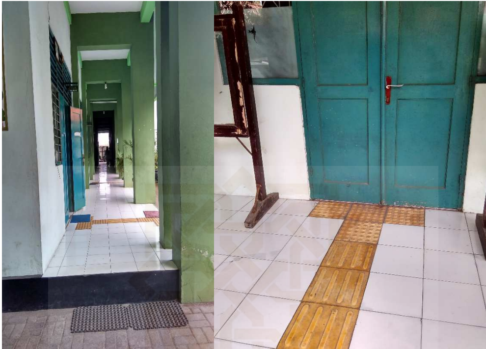
Depan pintu terdapat lantai yang kasar guna memudahkan anak ABK mengetahui kalau didepan ada pintu
