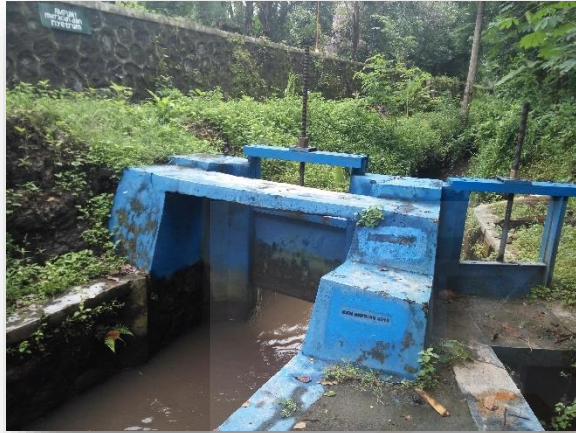
Gambar 2.5 Bendungan PLTMH Singosaren Sumber: Dokumentasi Pribadi
