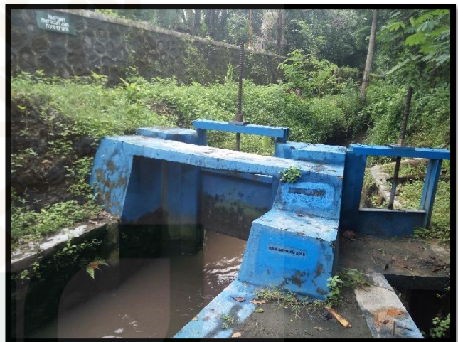
Gambar 3.5 Bendungan PLTMH Singosaren Sumber: Dokumentasi Pribadi
