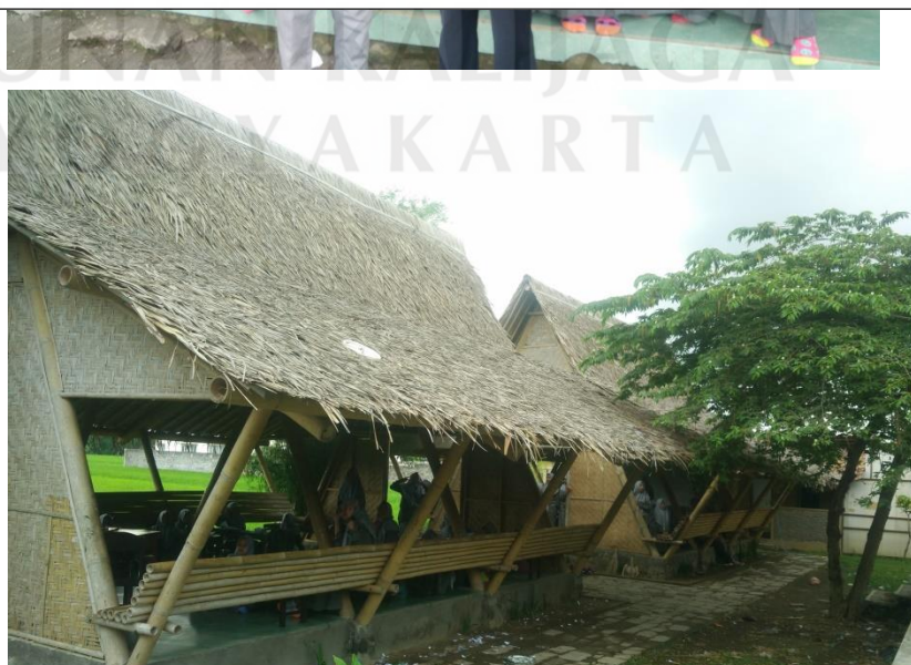
Gedung Ruang kelas MTs Assalafiyah yang unik, tradisional, dan konsep natural/alamiah.
