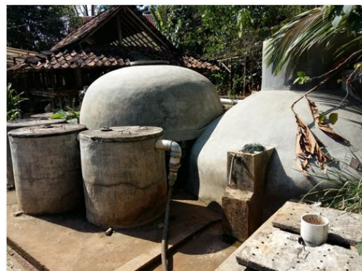
Dokumentasi 3 BIO GAS DIGESTER
