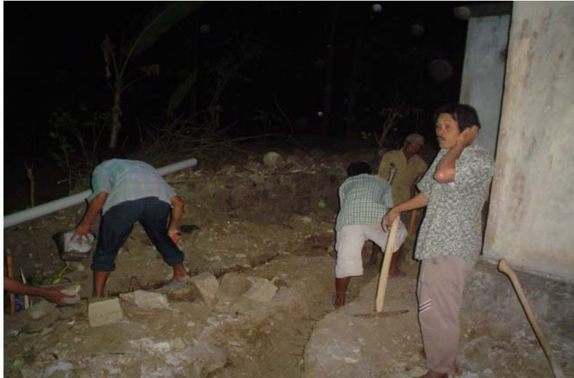
Gotong Royong Pembangunan MCK Masjid
