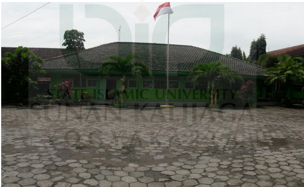
Gedung SMP Negeri 1 Pleret Bantul Yogyakarta
